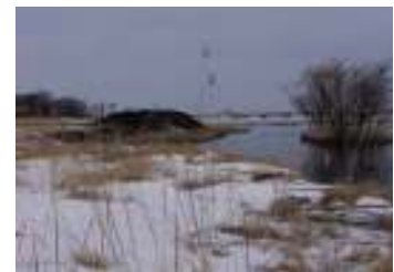
浦士別川河口の土砂浚渫
